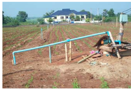
(2) บ่อน้ำบาดาลเจาะลึก 30 เมตรจากผิวดิน
